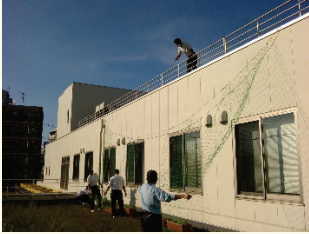
9. ネット設置時の様子
